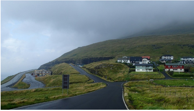
FRO-011 Hústoft Den nordvestlige skråning har to sektioner over 20 %.
