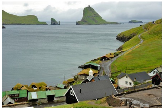
FRO-018 Húsadalsvegur A sea wall
