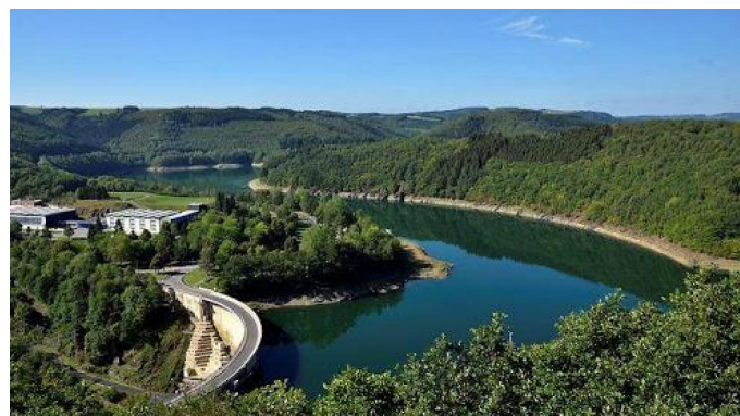
Le lac-barrage de la Haute-Sûre
