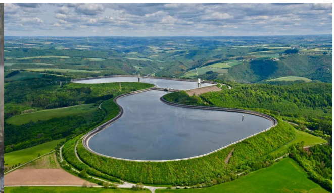
The Vianden upper basin on Niklosbiërg
